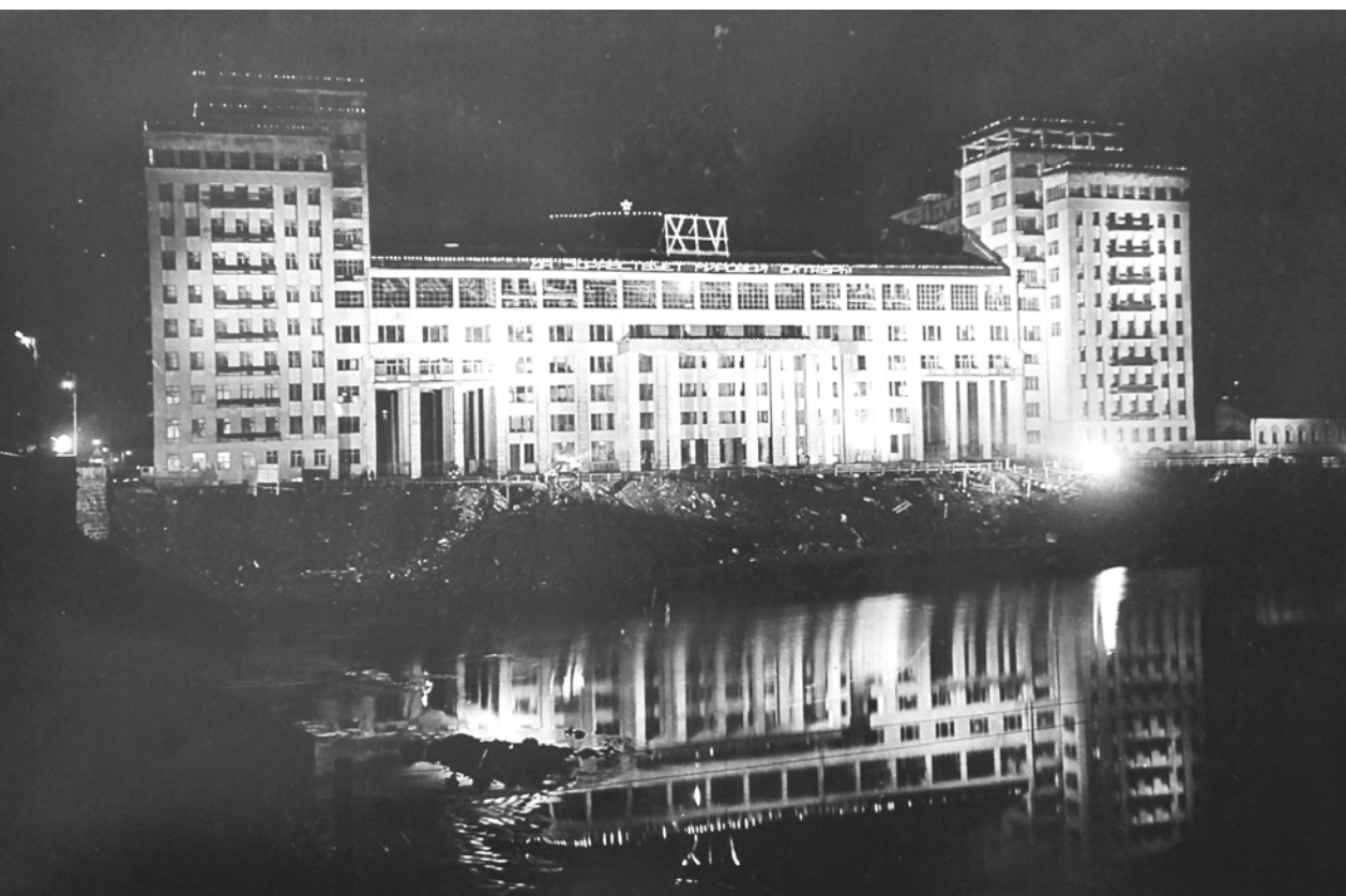
Las obras de la Casa del Gobierno casi acabadas. La iluminación era para celebrar el XIV aniversario de la revolución en noviembre de 1931. Fotografía incluida en el libro La casa eterna , de Yuri Slezkine.
