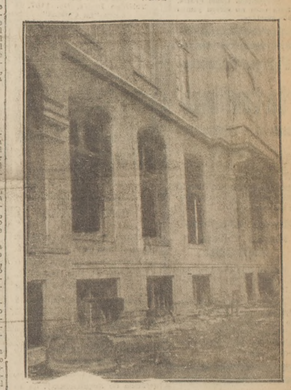
El Club Alemán después del incendio
