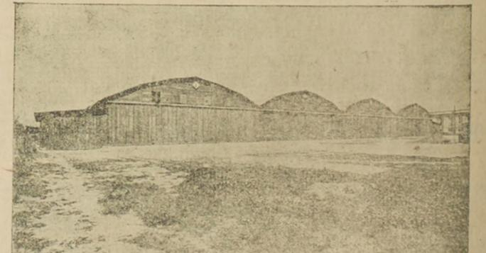
Fotografía tomada del techo de los Hangares de la Escuela de Aviación del Ejército, sobre el cual se colocó este material en el año 1913, sobre una superficie de 4,000 metros cuadrados, y está en las mismas condiciones que cuando se colocó, probando que este material se adapta al clima del país.
