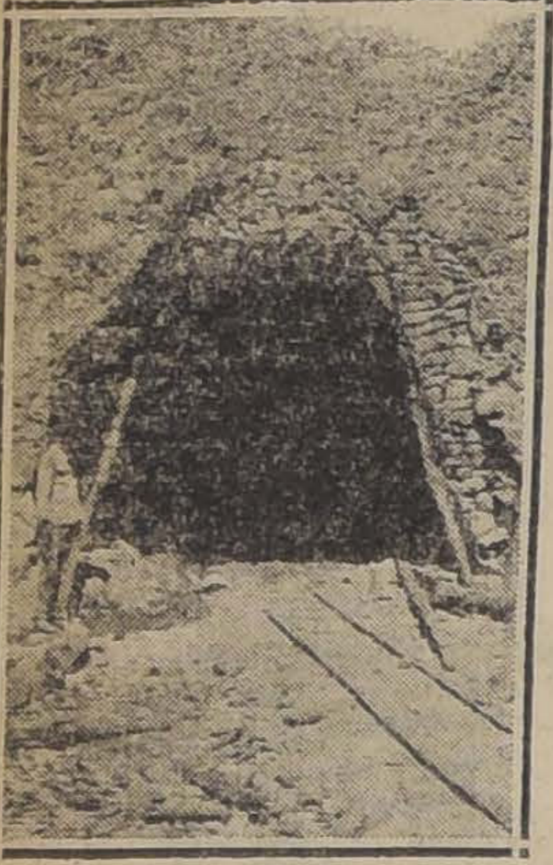
UNA DE LAS BOCA-TUNELES
