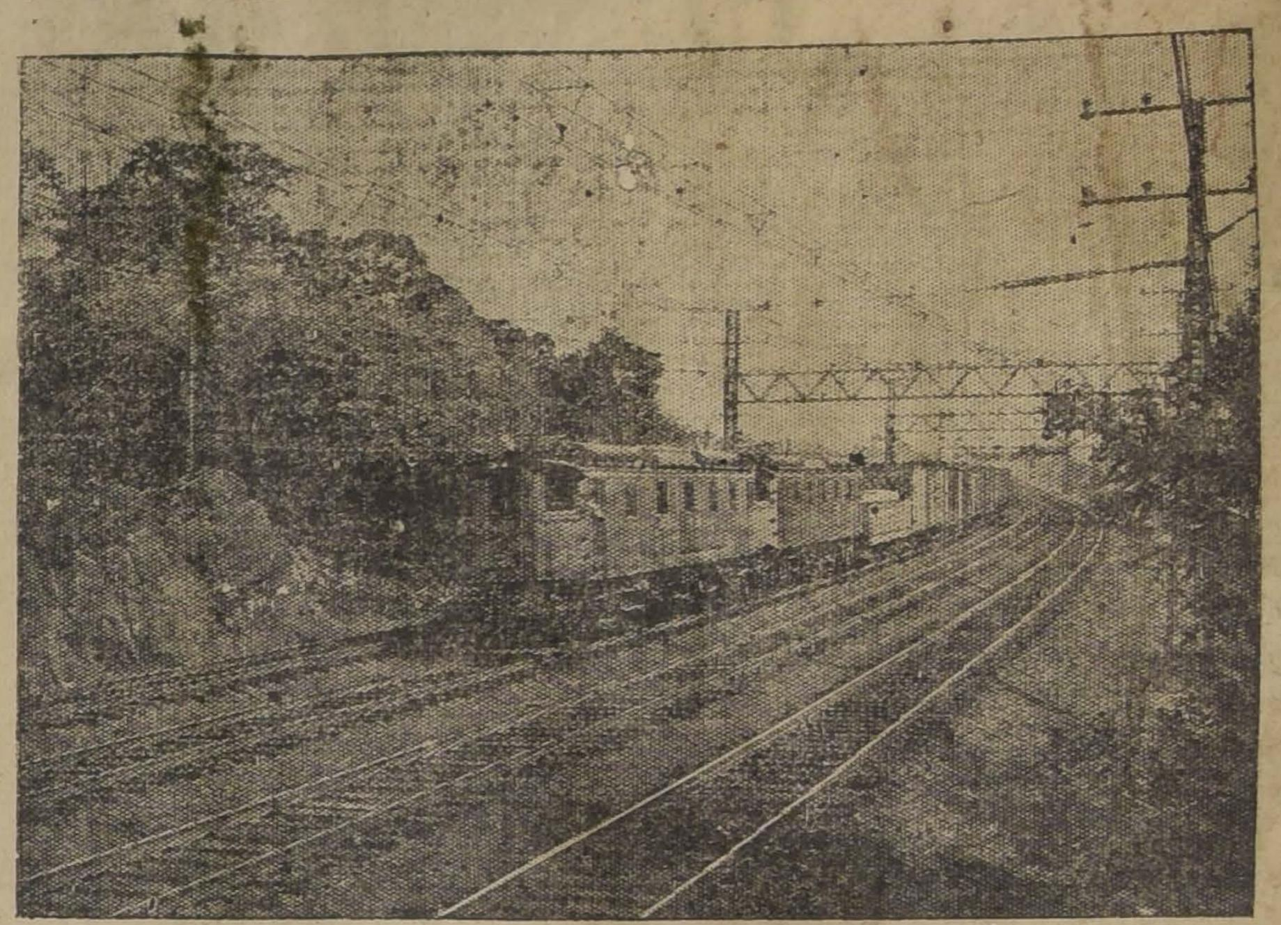
Electrificación del Ferrocarril de New York, New Haven & Hartford. Dos Locomotoras Eléctricas Westinghouse
