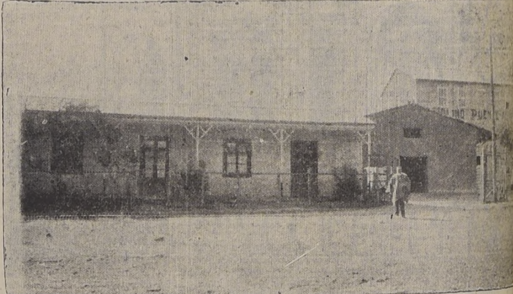
CASA HABITACION DEL MOLINO
