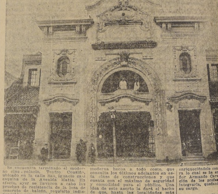
Se encuentra terminado el moderno cine-palacio, Teatro Cousiso, ubicado en la calle San Ignacio casi esquina de la Avenida Matta. En efecto, ayer se llevaron a cabo las pruebas de resistencia de la losa de concreto de balón, requisito indispensable para proceder a la colocación de las butacas. Último trabajo que falta para ser entregado al público. La visita que efectuó el Director de Obras Municipales al Cousiso, causó la mejor impresión en el ánimo de estos funcionarios, quienes tuvieron palabras de felicitación para el señor Manuel Cifuentes, autor y director de la obra.
