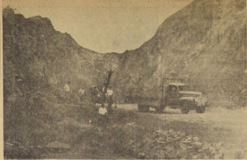
TRABAJOS FINALES EN VARIANTE SANTOS OSSA.— En 1959 se dio estructura final a la nueva variante caminera de Santos Ossa...
