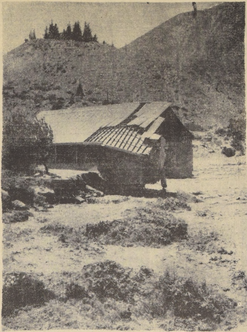
El desborde del Rio Yeso, en el sector cordillerano del Cajón del Maipo, ha dejado temporalmente fuera de servicio el acueducto que va desde Laguna Negra a Las Vizcachas...
