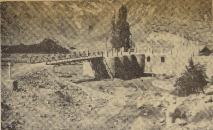
LA BOCATOMA FUERA DE SERVICIO.— Esta es la bocatoma de San Nicolás, a siete kilómetros de Santiago. La Empresa de Agua Potable la ha dejado fuera de servicio, porque el mayor caudal del Río Yeso — que es barro líquido — penetra a las cá-
