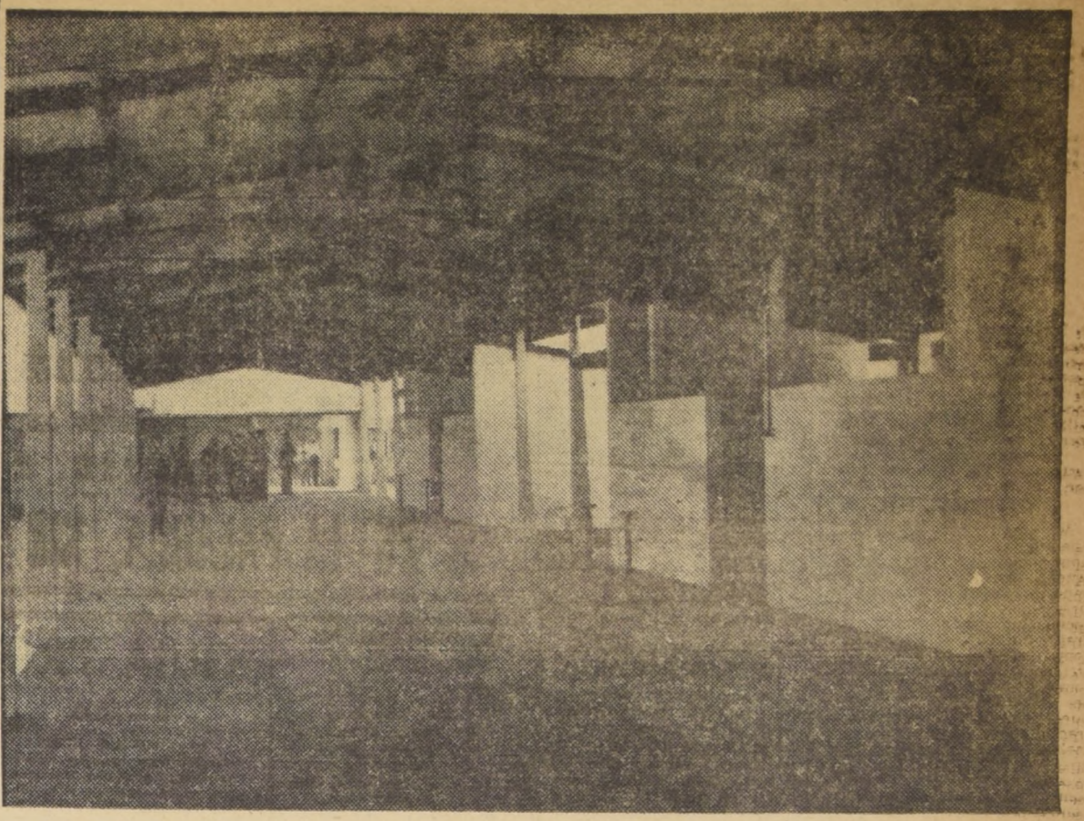
Una vista parcial del patio techado de la Escuela San Gregorio, construida por "ABALOS Y GONZALEZ LTDA.". Muestra las características de su construcción por el sistema exclusivo "HELLENIT", de postación y paneles de concreto armado, de fabricación propia.
