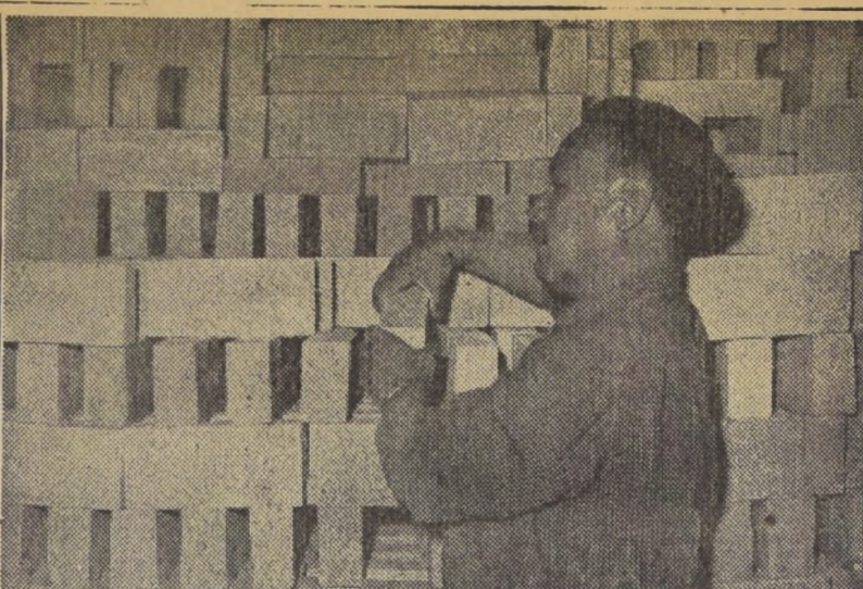
DECANO CERAMISTA.— Los problemas de cocido, temperaturas, mezclas y todo lo que tenga que ver con el oficio de la cerámica, no tienen secretos para el obrero Juan Labra Palma. LA NACION lo sorprendió preparando una carga de ladrillos refractarios en el interior del horno de la fábrica "San Antonio".
