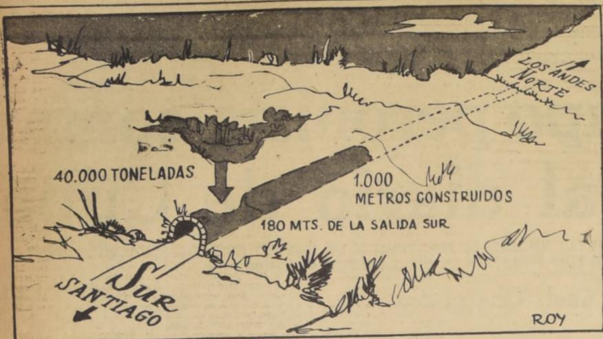
EL CROQUIS muestra claramente las características del derrumbe del túnel Chacabuco. La flecha indica la parte que "se sentó", destruyendo una parte ya terminada en la que trabajaban dos operarios. La avalancha creó una chimenea que sale a la ladera exterior del cerro, precipitando 40 mil toneladas de material al interior del túnel. Esta vía está construida ya hasta la mitad, como puede advertirse en el grabado, faltando el tramo que se indica con línea punteada.
