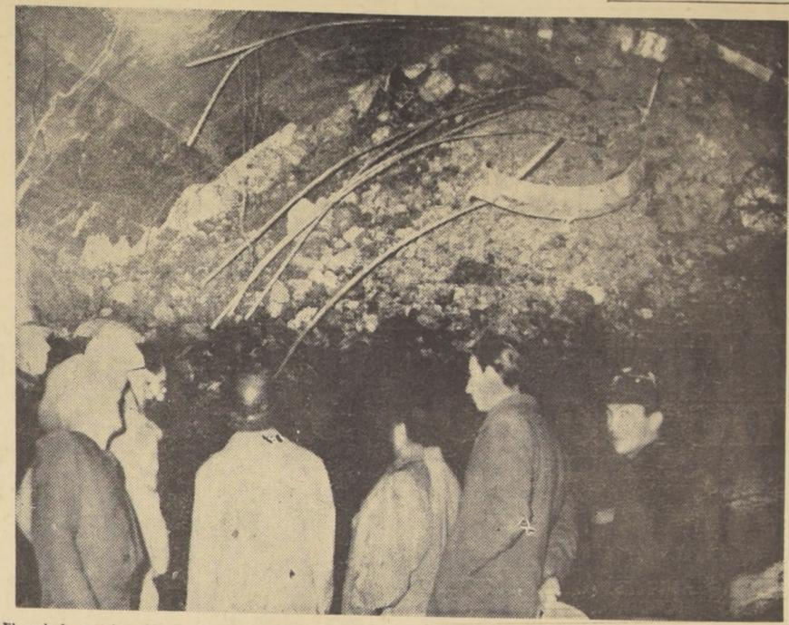
El grabado muestra cómo quedó el túnel Chacabuco, en la ruta Santiago-Los Andes, después del derrumbe de 40 mil toneladas de material, que dio muerte a dos obreros y destruyó una sección ya construida. El grabado, de Hernán Castillo, exhibe la parte exterior del derrumbe, que tiene una profundidad indeterminada y una altura de 84 metros, hasta la ladera misma del cerro, por la superficie exterior. (INFORMACION PAG. 6.)
