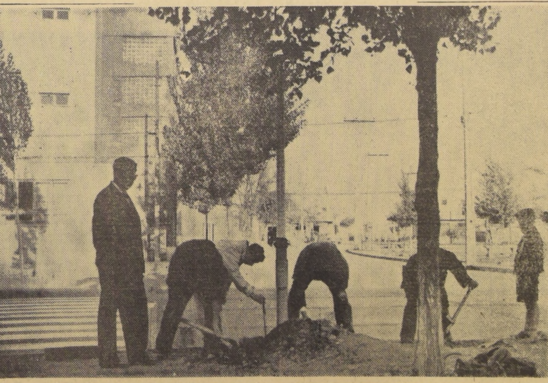
Frente al Grupo Escolar "Pedro Aguirre Cerda", ubicado en la Avenida del mismo nombre, donde el intenso tránsito de toda clase de vehículos se hace en doble sentido, urge colocar un señalizador automático. Y en la sesión del miércoles se aprobó el informe de la Comisión de Finanzas e Inversiones que consulta el gasto para realizar esta obra, que es fundamental para la seguridad de los tres mil niños que concurren a esos establecimientos educacionales. El acuerdo incluye también la instalación de un semáforo en el cruce de la Avenida mencionada con San Joaquín. Pero como el trabajo tenía que hacerse pronto, ayer comen zaron las faenas preliminares, de las cuales el grabado muestra un aspecto. Un alumno observa la labor de los obreros.
