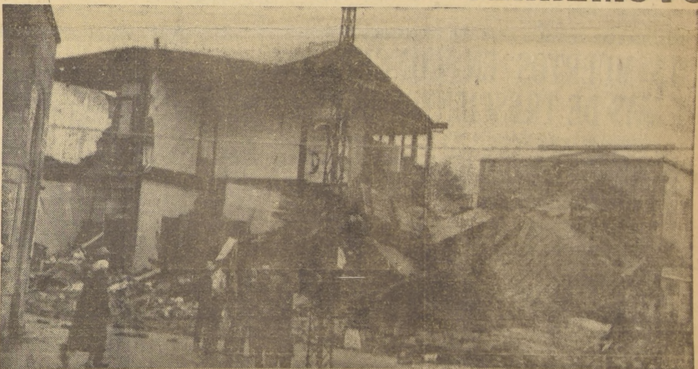
EPICENTRO DEL TERREMOTO.— Nuevamente Concepción enluta su historia. El sismo que se sintió ayer en todo el país dejó en la progresista capital penquista el mayor número de víctimas y de daños. En el grabado se puede apreciar una casa del sector viejo de la calle O'Higgins esquina de Ongolmo, destruida totalmente por el violento sismo de ayer. El edificio que la enfrenta quedó con un peligroso desnivel que hizo necesaria su inmediata remoción para evitar otras desgracias. Este dramático aspecto es una de las primeras fotografías llegadas a Santiago; comprueba que los inmuebles afectados por el movimiento terrestre pertenecen, principalmente, a la edificación antigua, hecho que avaluó un más trágico balance. Pese a esta nueva desgracia, la población penquista, como lo dijo ayer el Ministro del Interior, es enfrentada con gran serenidad y disposición para superarla.— (Amplias informaciones en páginas 2, 4 y 9.)
