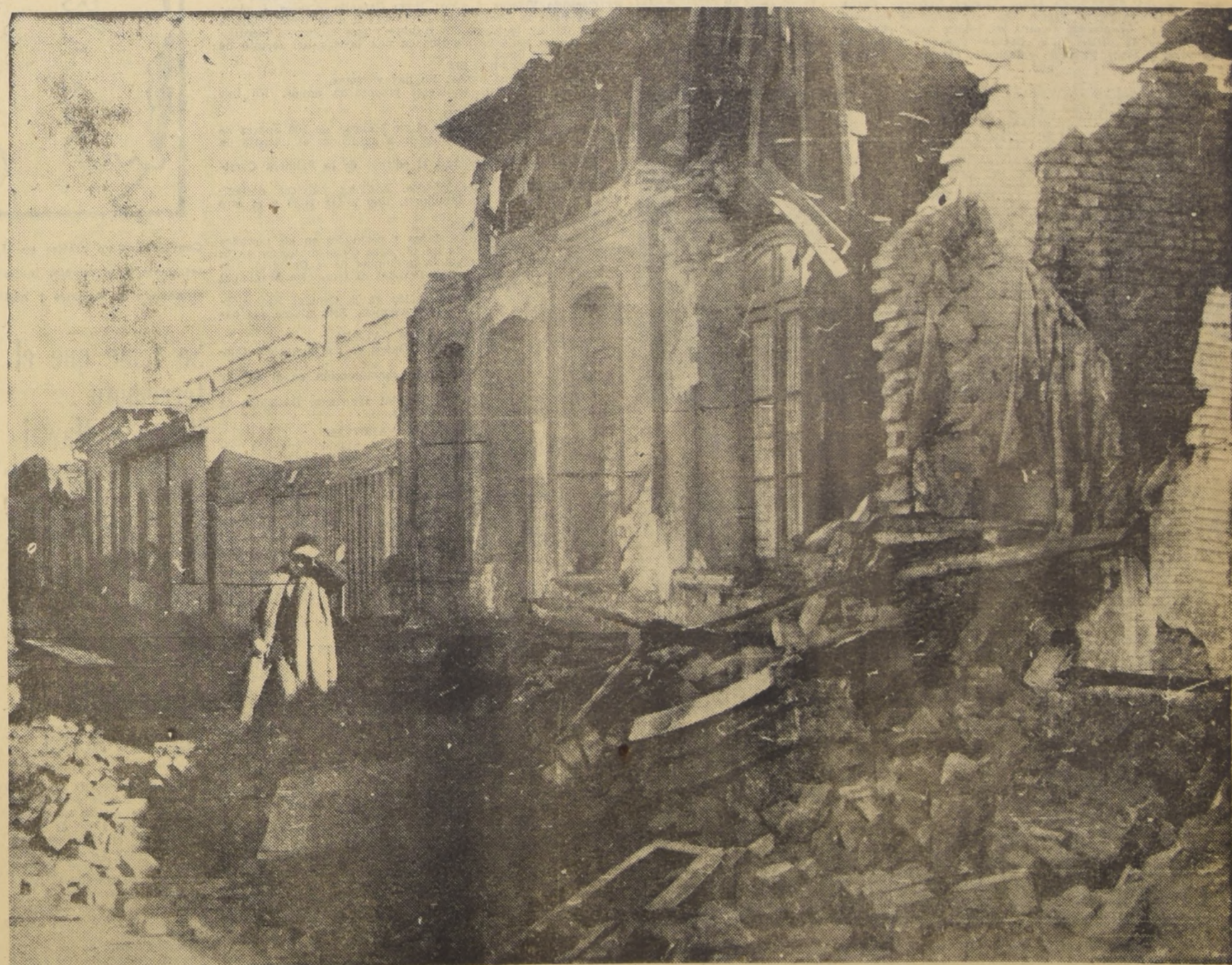
ESCOMBROS EN LAS CALZADAS.— Los viejos edificios de la calle Los Carreras, de Concepción, por la fuerza del movimiento sísmico llenaron de escombros las calzadas al no resistir el impacto del terremoto. EN EL GRABADO, un veciño observa los destrozos causados por el sismo en esta arteria penquista.
