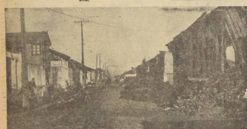
LA CALLE OROMPELO. — Así quedó la calle Orompello, del barrio Plaza Condell, en Concepción. En primer plano, se advierte un viejo edificio derrumbado. Casi siempre los frentes cayeron hacia el lado exterior, liberando las plazas interiores con daños menores.
