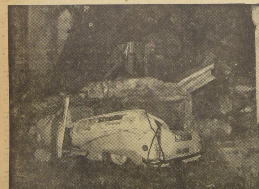
FRENTE AL DIARIO "LA PATRIA". — En la calle Colo Colo, frente a las oficinas del diario "La Patria", se registró este testimonio evidente de la violencia del sísmo. Un furgón de reparto quedó hecho añicos al caer encima un trozo de cornisa de doce metros de largo y varias toneladas de peso.
