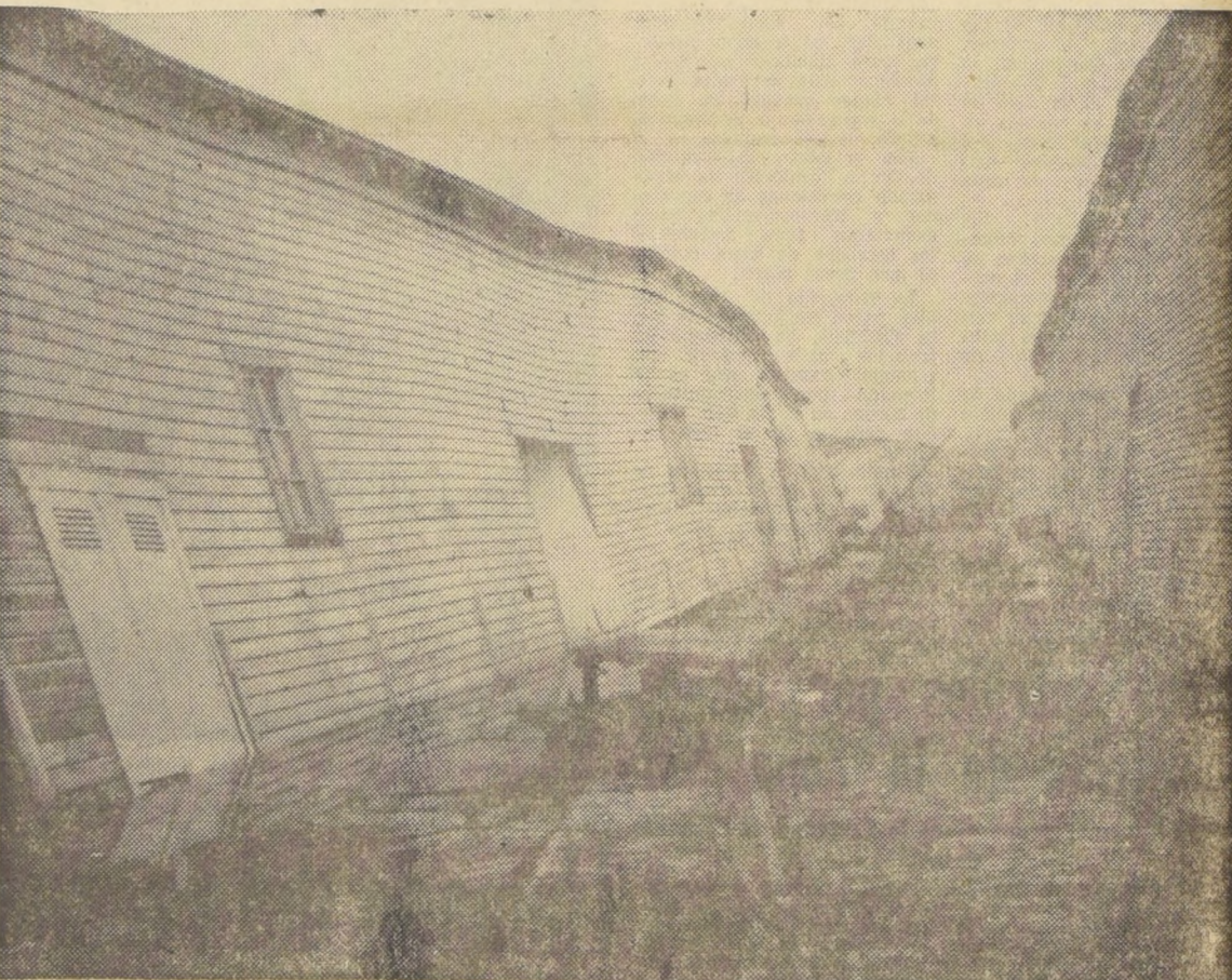
LAS BODEGAS DEL PUERTO cayeron al mar y sus calles se abrieron como mantequilla, como puede apreciarse en el grabado. Esta foto de los destrozos causados por el terremoto en Puerto Montt, revelan la cuantía de los daños.
