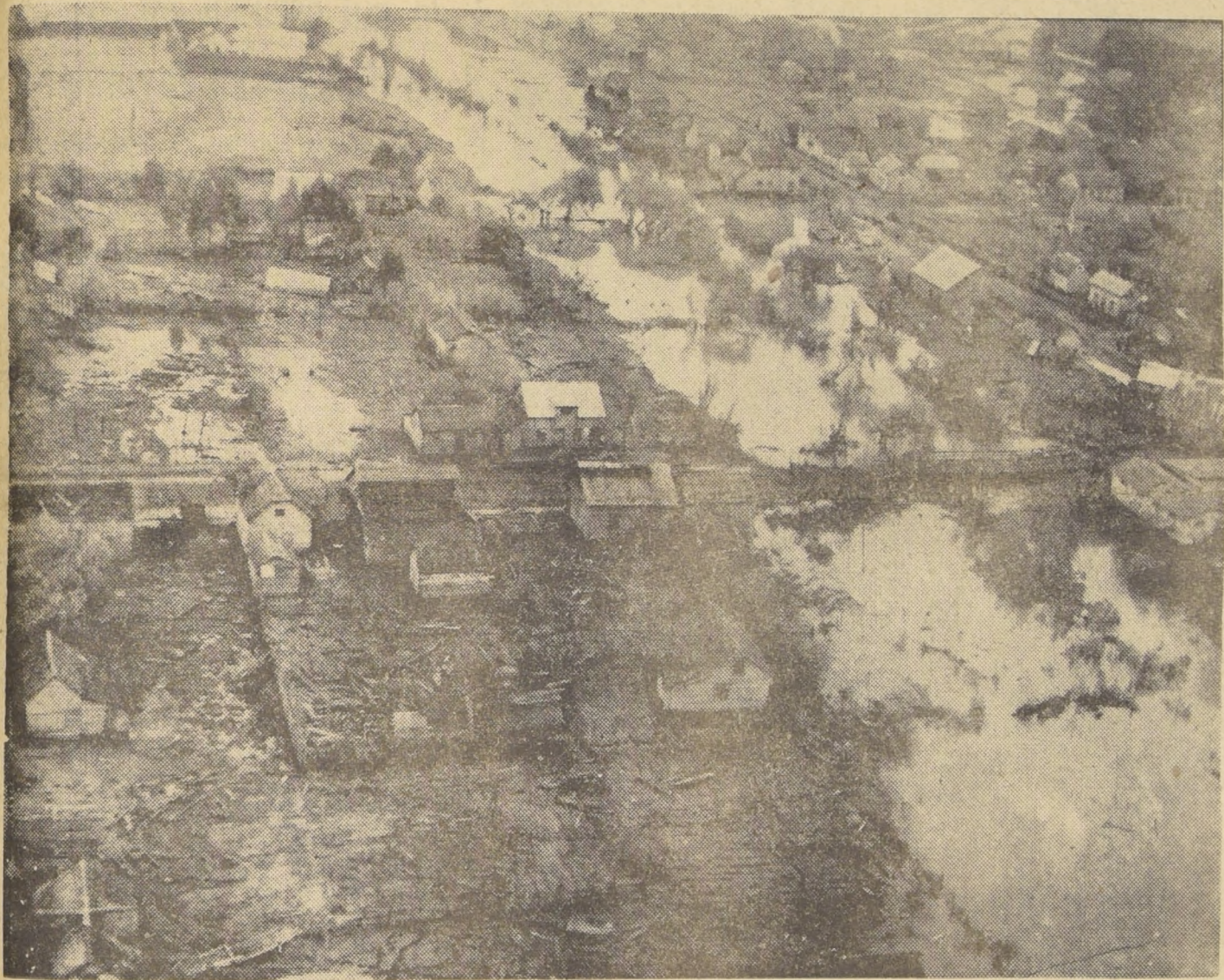
ASI QUEDÓ CARAHUE.— La presente vista aérea muestra el estado de destrucción en que quedó Carahue después del sismo del domingo último. Puede apreciarse el gran número de casas virtualmente demolidas.— (Foto de Víctor Rojas.)
