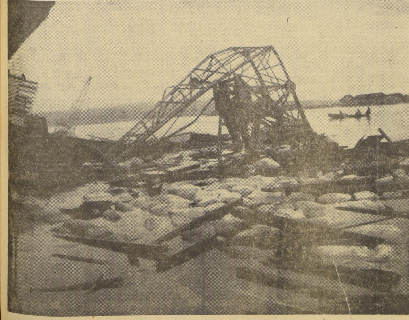
El sismo, cuyos efectos han cambiado la geografía de Chile en región sur, muestra su efecto devastador en el muelle de Puerto Montt. La antes poderosa grúa ha sido doblada como si fuera de alambre.
