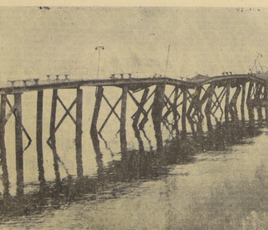
LA FUERZA DEL MOVIMIENTO y el impacto del mar dejó en estas condiciones al muelle carguero de Puerto Montt. Poco a poco, el mar se irá tragando a este muelle que más se asemeja a un acorreado. Nada de lo que fue el puerto queda ya en la aislada ciudad de Puerto Montt.
