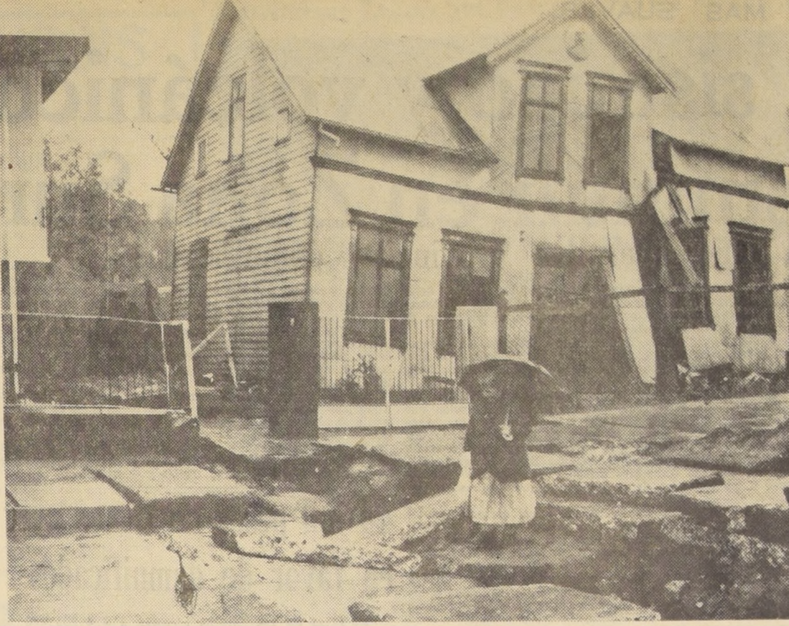
DESTRUIDO HASTA EL PAVIMENTO. No sólo las casas fueron destruidas por la fuerza de los terremotos. El pavimento de las calles, que estalló como una granada...
