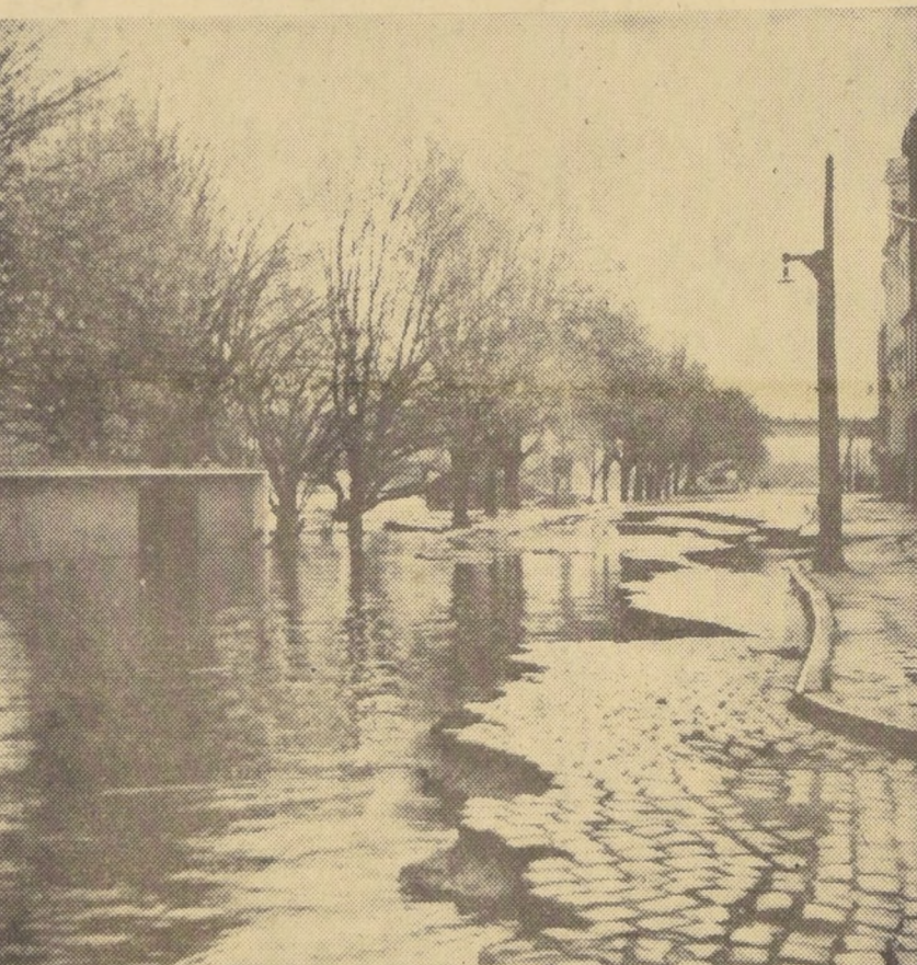
AGUAS INVADEN LA CIUDAD.- Esta escena no corresponde a un río, ni a un lago. Es como quedó convertida la calle Pizarro, de Valdivia, después del sismo y del maremoto. Sus calzadas se partieron por efectos del movimiento de tierra y las aguas invadieron la vía anegando calles y casas. El grabado es elocuente, pero da sólo una pálida idea de las consecuencias que tuvo la catástrofe.
