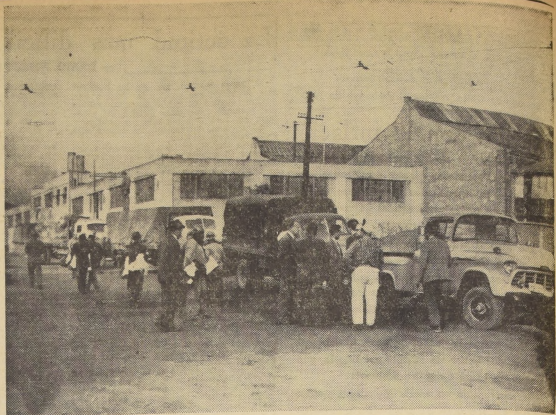
En la tarde de ayer partió a la zona afectada por los sismos y maremotos una caravana técnica organizada por la Compañía Chilena de Electricidad, que lleva equipos humanos y electrogenos para colaborar en la instalación y distribución de elementos eléctricos en las localidades que más lo necesitan. En la foto, el presidente de la Cia., don Arturo Aldunate, con ingenieros, operarios y elementos que partieron al sur.
