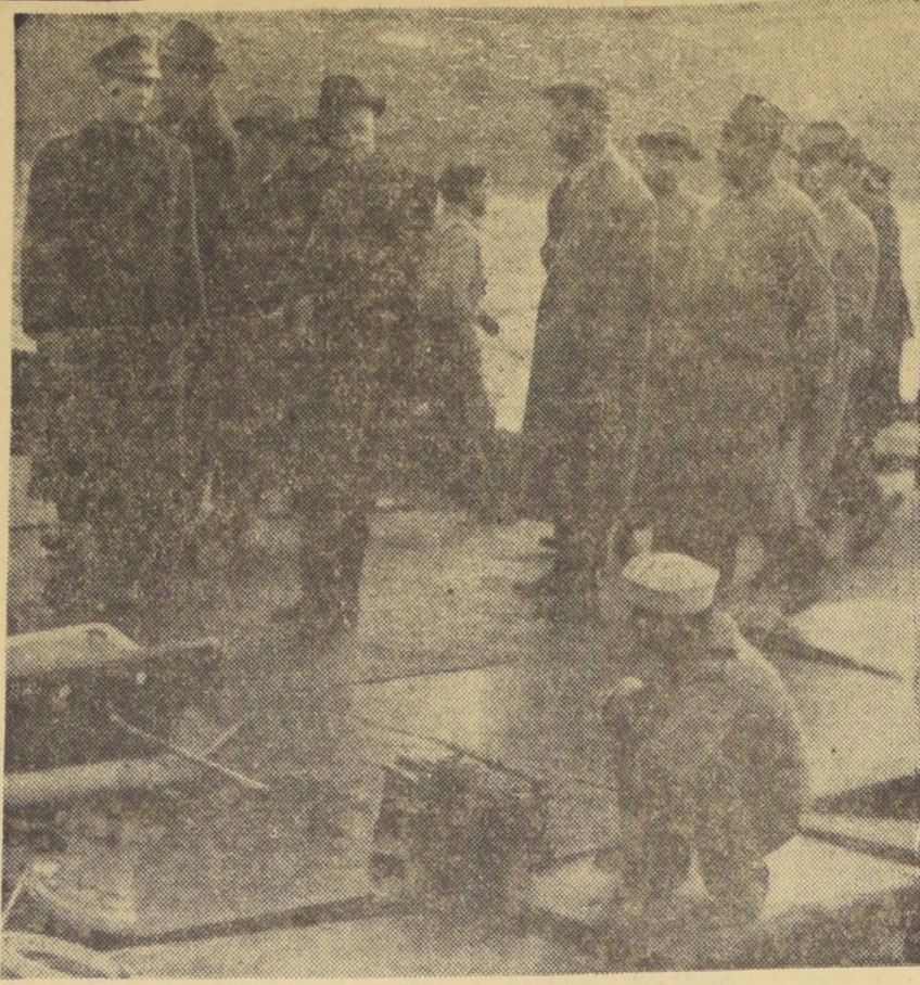
DAÑOS EN EL MOLO. — El Ministro de Justicia y Tierras, Julio Philippi, examina los enormes daños causados en el molo de Valdivia por el terremoto de la mañana del domingo 22 de mayo. Un pequeño damificado lo observa con curiosidad. Los perjuicios en la zona portuaria, tanto de Valdivia como de Puerto Montt, son de difícil estimación. Se inspecciona más acuciosamente la región asolada, puede apreciarse en toda su demoledora magnitud la catástrofe.
