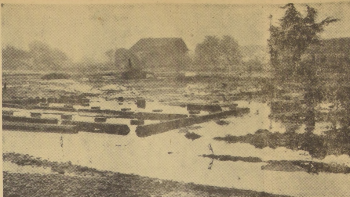
RECONSTRUIRAN PUERTO SAAVEDRA, aunque no precisamente aquí, en su antiguo emplazamiento, en donde el mar arrasó con la mayoría de las viviendas y edificios...
