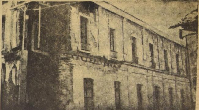
Ilustración 23. Efectos del terremoto sobre una casa de albañilería en la ciudad de Cauquenes, Chile. Durante el movimiento sísmico las dos fachadas tendieron a separarse, causando el derrumbe completo de la esquina, facilitado por la solución en ochavo, llevando también el entramado de piso.
