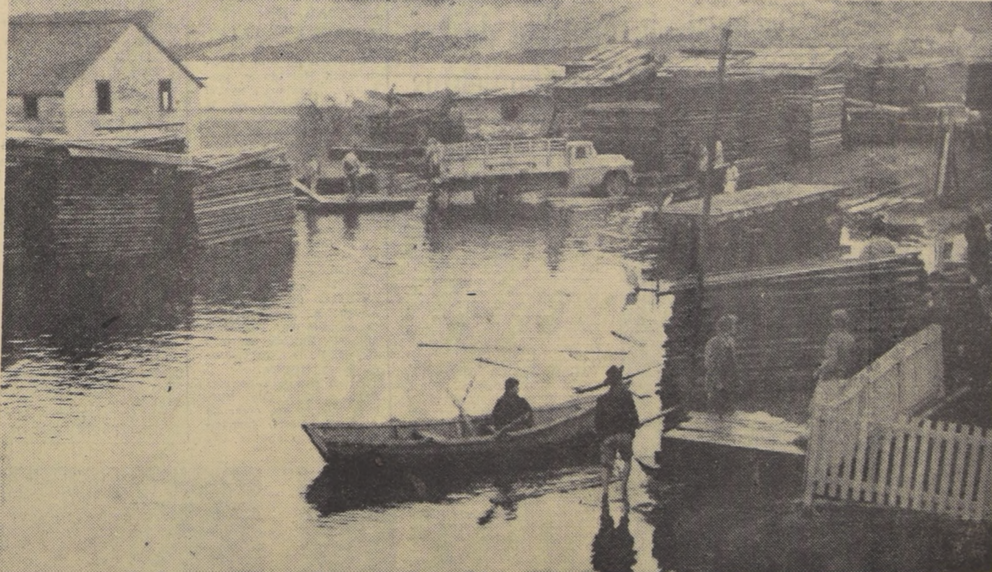
SALVANDO LA MADERA. — Los Lagos, centro fundamentalmente maderero, trata dramáticamente de salvar la mayor cantidad posible de sus existencias en este producto esencial para la reconstrucción. En el grabado, puede verse un grupo de obreros que trabaja para alejar las rumbas de tablas de la parte inundada. (Fotos de Víctor Rojas, enviado especial)
