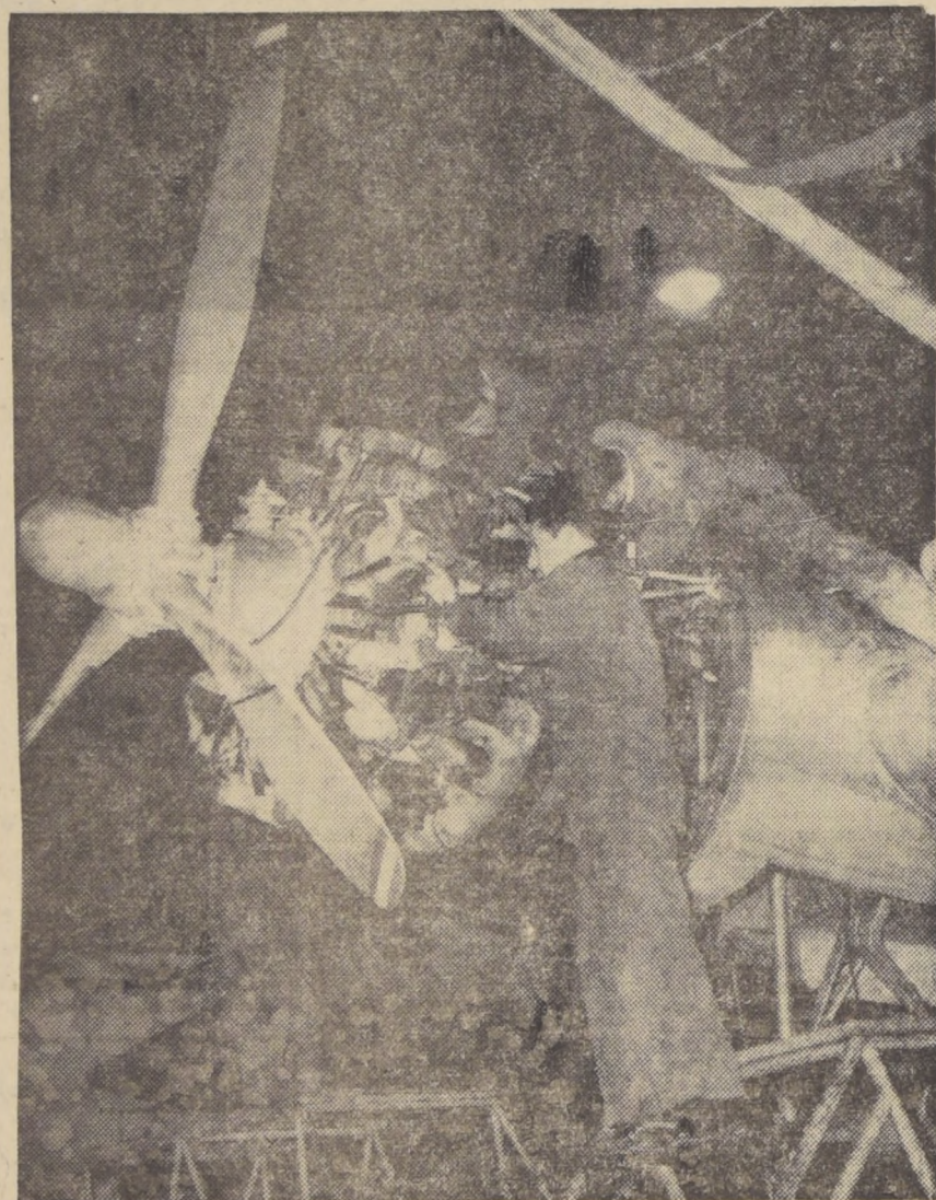
MANTENCION VITAL. — En turnos de noches, los personales de mantenimiento del Grupo N.º 10 de Transporte de la FACH, revisan todo tipo de aparatos, para que estén en condiciones de volar al día siguiente. En el grabado, mecánicos de dicha unidad inspeccionan el motor de un DC-3.
