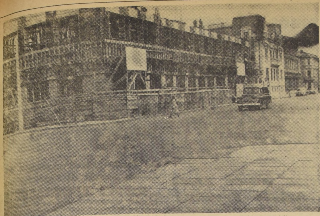
Edificio en construcción del nuevo Hotel Turismo en Punta Arenas, ubicado frente a la Plaza Muñoz Gamero de esa ciudad. La propiedad pertenece a la Sociedad Explotadora de Tierra del Fuego, constará de seis pisos, y tiene un costo aproximado de un millón de escudos.
