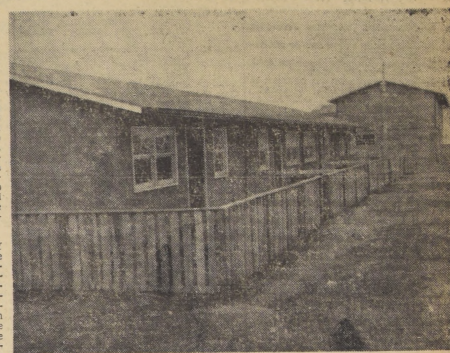
Modelo de casas construidas por la Corporación de la Vivienda en Punta Arenas, para importantes. Recientemente la institución entregó 210 casas de tipo económico, en su contribución a la solución del problema de la vivienda en la zona austral.
