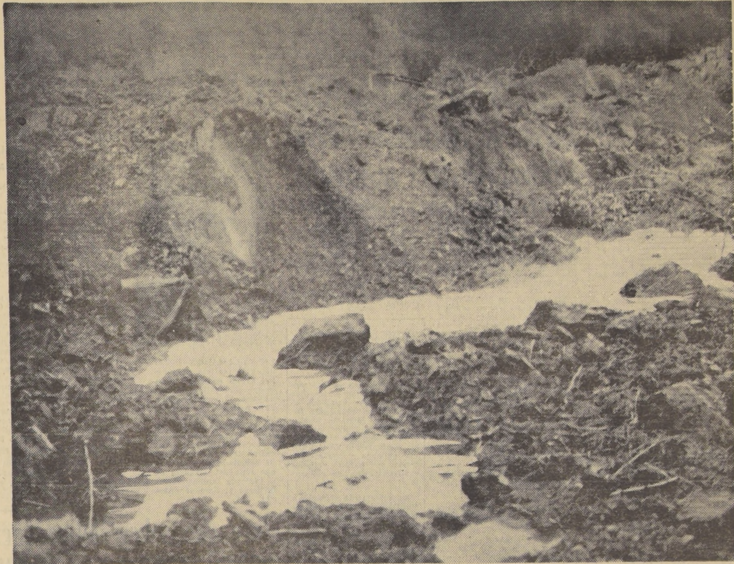
TODAVIA NO SE CONOCE el término imposible en la denodada tarea que se realiza para contener la tremenda amenaza del Riñihue. Todas las informaciones alarmantes, respecto a una súbita y destructora avenida, son infundadas. Donde las máquinas no pueden llegar, está el esfuerzo del hombre. Así, a mano, se está excavando una acequia para conectar el lago con la poza de agua detenida entre el tacho 1 y 2. Tan increíble esfuerzo, aleja, en mucho, el peligro de un aluvión. El grabado muestra con elocuencia, el lago abierto entre los cerros, para permitir el desahue del enorme caudal acumulado.
