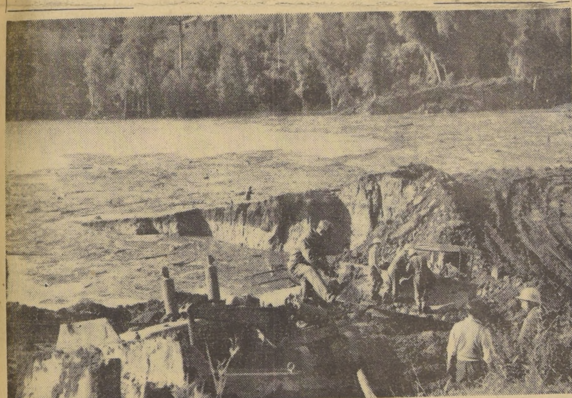
DIECISEIS MAQUINAS como las que muestra el grabado continúan trabajando en el tacho número 3 del río San Pedro, desaguadero del lago Riñihue. Las excavaciones entraron a remover ya terreno firme, no barroso, esperando completar el canal antes del 26 del mes en curso, nueva fecha del aluvión calculada por los técnicos. Nótese que las cuadrillas y los Bulldozers trabajan a escasos metros de las aguas y bajo el nivel de éstas.
