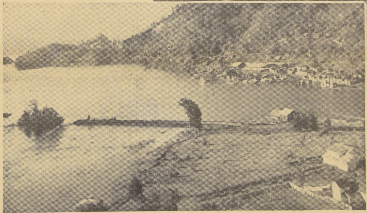
CONSTRUYEN DIQUE.— En forma acelerada avanzan los trabajos de construcción de un dique en el río Enco, que servirá para regular la corriente que desagua el lago Panquipulli hacia el lago Riñihue. EN EL GRABADO puede apreciarse la magnitud de la obra que se está realizando en el citado lugar. Al fondo, un aspecto del pueblo de Enco, a la orilla del Panquipulli.
