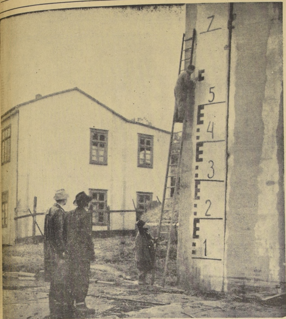
NIVELES DEL RIO.— La Universidad Austral de Valdivia realizó un estudio sobre los niveles de las aguas para determinar el máximo de la cota de inundación al producirse la avenida del lago Riñihue. EN EL GRABADO, personal de la Universidad marca los índices que parten de "0" sobre las aguas del río.— (INFORMACION EN PAGINA 12)
