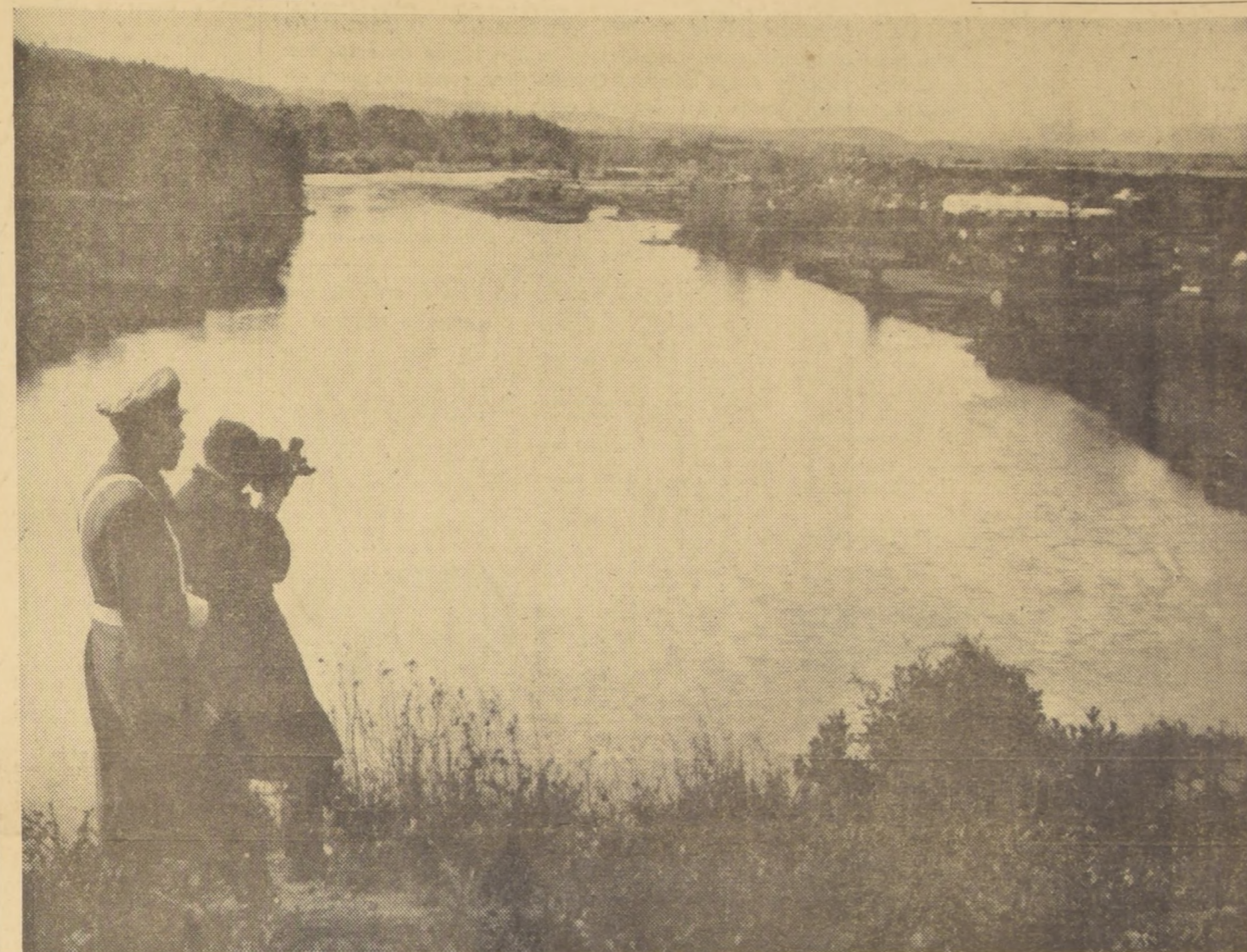
LOS LAGOS, pueblo valdiviano de apacible existencia hasta antes del 21 de mayo, será la primera víctima de la avenida de agua que, desde el Lago Riñihue, se descolgará hacia el lecho del Río San Pedro. Su población ha sido totalmente evacuada. EN EL GRABADO, un cameraman y un carabinero observan el paralizado pueblo.
