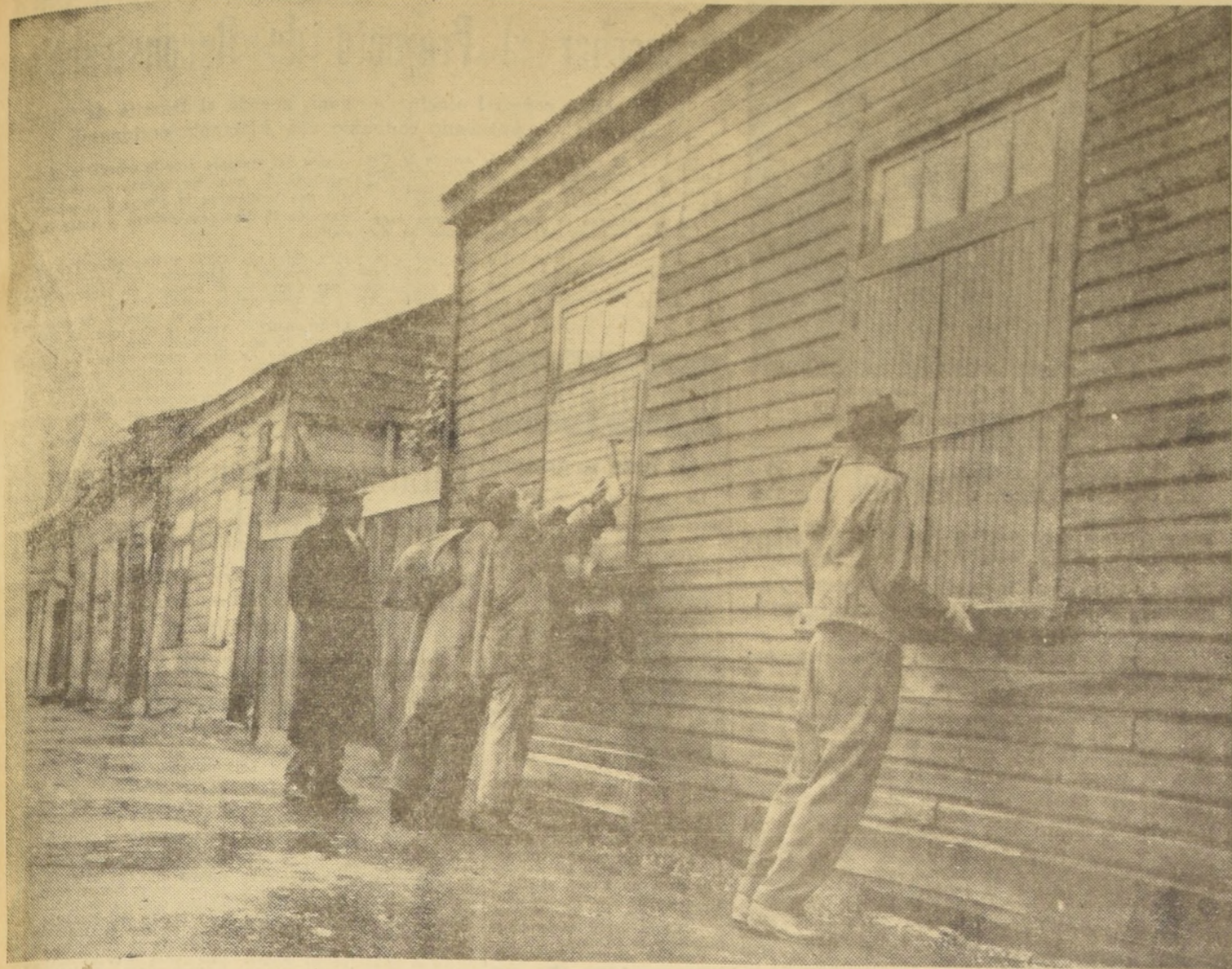
VECINOS DE ANTILHUE refuerzan las ventanas de un establecimiento comercial de propiedad de Lizardo Uribe, ubicado en calle Comercio 297, a corta distancia del río. Uribe es el único que, junto con su esposa y sus hijos —Isidro, de 27, y Antonieta, de 11 años—, aún se mantiene en el pueblo, y su comercio permanece aún abierto. Los transeúntes son sus ocasionales clientes.
