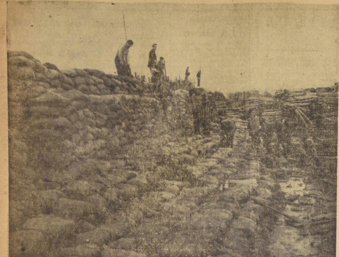
DEFENSAS CONTRA EL RIÑIHUE.— Febrilmente se tra baja en la zona ribereña del Calle Calle, construyendo defensas para evitar que el inminente desborde del lago Riñihue abarque una extensión de Valdivia mayor que la calculada por los técnicos que operan en el control de las aguas. En el grabado, un grupo de obreros forma con sacos de arena una gigantesca muralla de contención en uno de los lugares ubicados en la zona de peligro.
