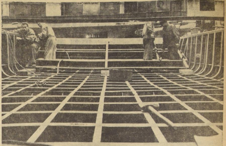
EL DOBLE FONDO PREVENTIVO.— Construida totalmente con acero de CAP, la primera barcasas que entregará al Ministerio de Obras Públicas, la "Fundación Libertad", cuenta con toda la estructura determinada por la técnica moderna. En el grabado se observa el doble fondo de la embarcación, construido en compartimientos de acero, para evitar percamas en caso de hacer agua
