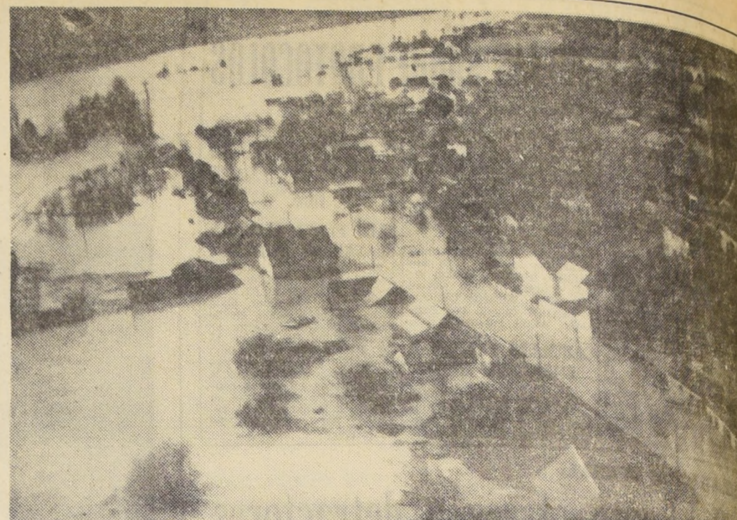
ANTILHUE, VICTIMA DEL RIÑIHUE — Antihue fue otro de los pueblos más afectados por la avenida que descendió del Riñihue. Las construcciones ribereñas que no fueron arrancadas de sus bases, o llevadas por las aguas, quedaron seriamente dañadas.
