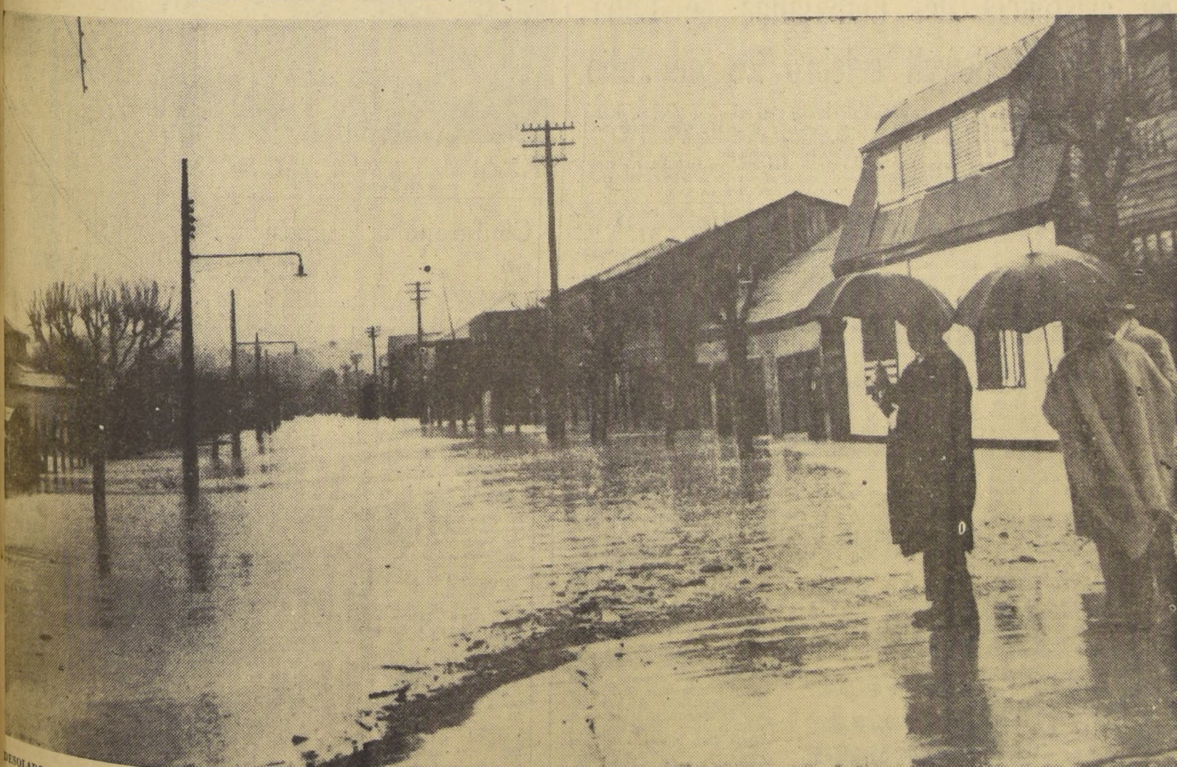
DESOLADO PAISAJE. — Aun cuando las aguas habían empezado a descender de nivel, el paisaje urbano de Valdivia seguía siendo desolador. El Ministro del Interior, acompañado por autoridades locales, observa un sector del barrio Las Animas, que resultó seriamente afectado por la inundación.
