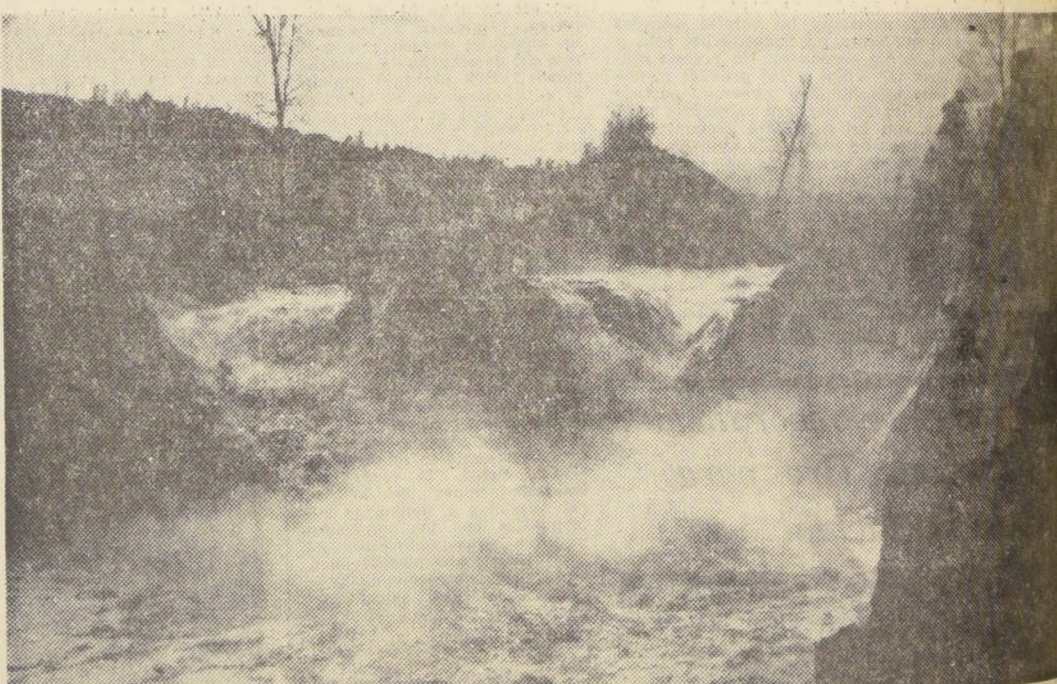
LA FURIA INCONTENIBLE — Esta fotografía muestra, en cierto modo, la fuerza incontenible con que se arrojó hacia su desagüero normal del río San Pedro, el agua acumulada en el lago Riñihue. Esta verdadera cascada se formó en el tacho 3. Son dos mil millones de metros cúbicos los que ha estado desaguando este lago.
