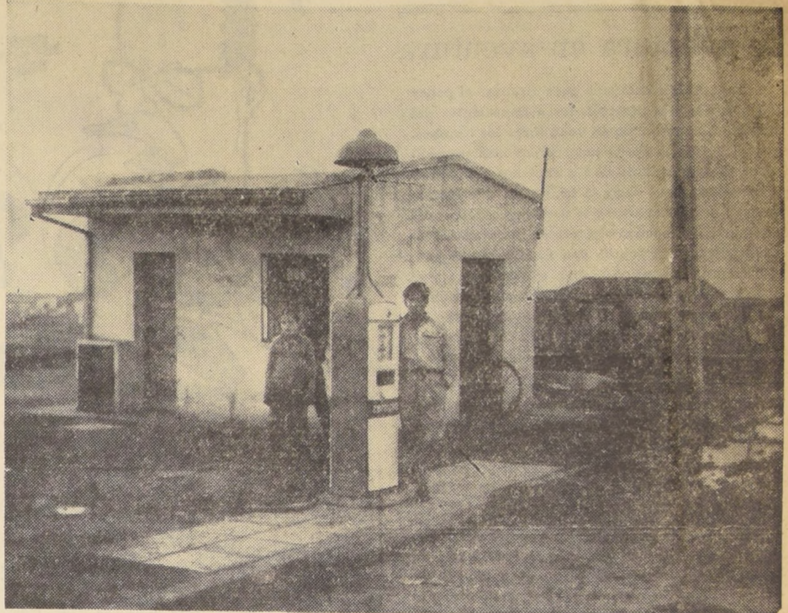
Población Victoria. Bomba de gasolina.
