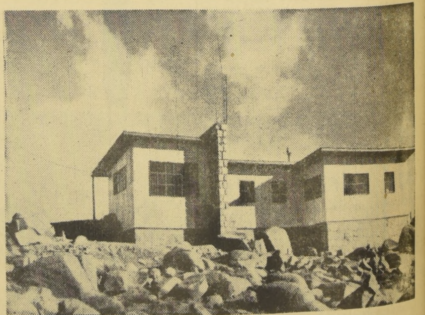
Estación de radio en el refugio Cerro El Roble a 2.200 mts. altura
