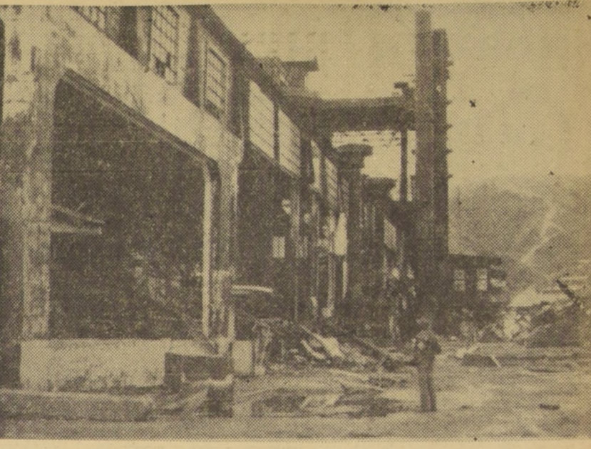
DEMOLICION DE ALTOS HORNOS.— Las instalaciones de la paralizada planta de Altos Hornos de Corral, recibieron todo el impacto de los grandes marejales provocados por el maremoto...
