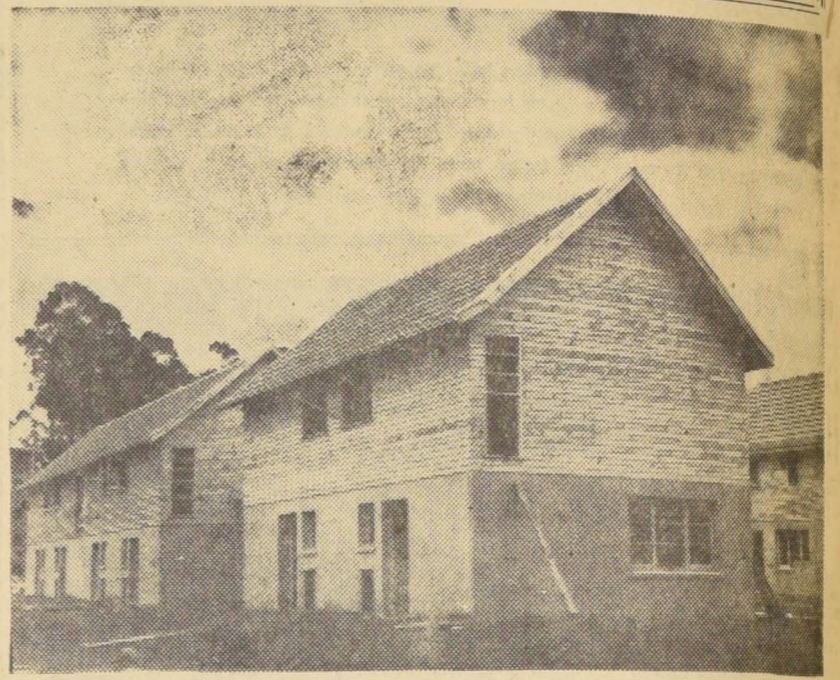
Con un ritmo creciente, se está construyendo en todo Chile, como nunca se hizo en toda la historia habitacional del país. En sólidos cimientos, con sistemas que consultan las mayores seguridades para el poblador, previstas todas las emergencias, así surge cada casa levantada por la Corporación de la Vivienda. El grabado muestra una población en Coronel.
