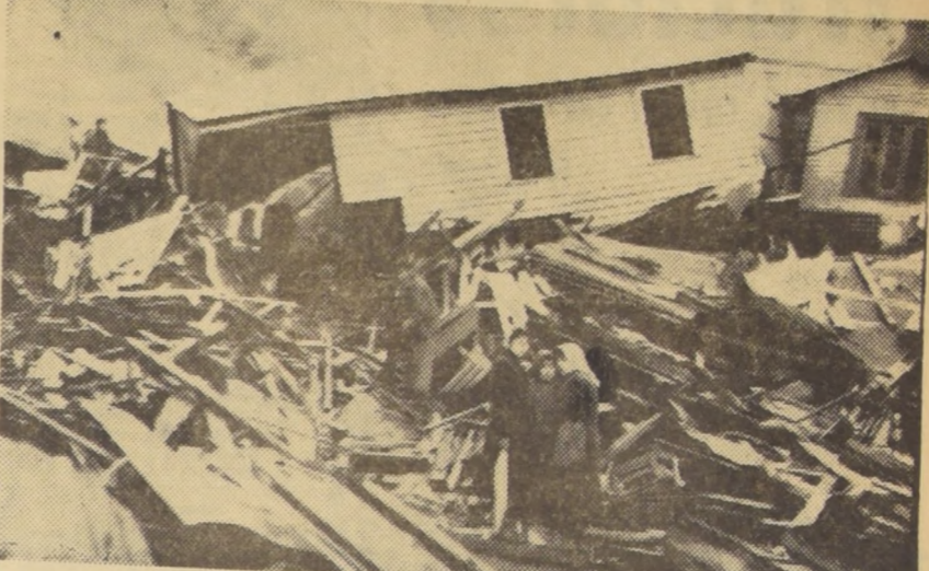
Esta escena de desolación y ruina sintetiza, en toda su dramática significación, lo que fue el desastre sureño. Ahora, la Corporación de la Vivienda, sin detener sus planes ordinarios tendientes a solucionar en todo el país el problema habitacional, está reponiendo las casas que arrasaron los sismos. Y mediante un eficaz sistema de préstamos para reconstrucción, contribuye al esfuerzo de cada familia afectada para tener nuevamente su hogar.
