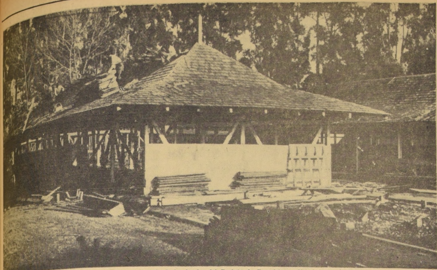
LA RECONSTRUCCION.— El terremoto derribó la mayor parte de los locales del Recinto de Exposiciones. No obstante, en tres meses se ha rehabilitado el local y este año se efectuará como de costumbre el torneo agrícola y ganadero de Osorno. En la fotografía, la faena de reconstrucción de corrales.
