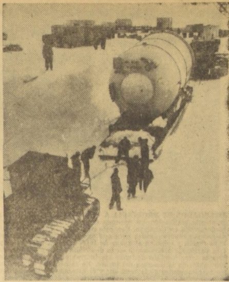
ENERGIA PORTATIL: Soldados del Cuerpo de Ingenieros del Ejército de EE.UU., que están instalando una planta de energía atómica portátil en Groenlandia, aparecen cuando arrastran un condensador de vapor, parte principal del sistema.
