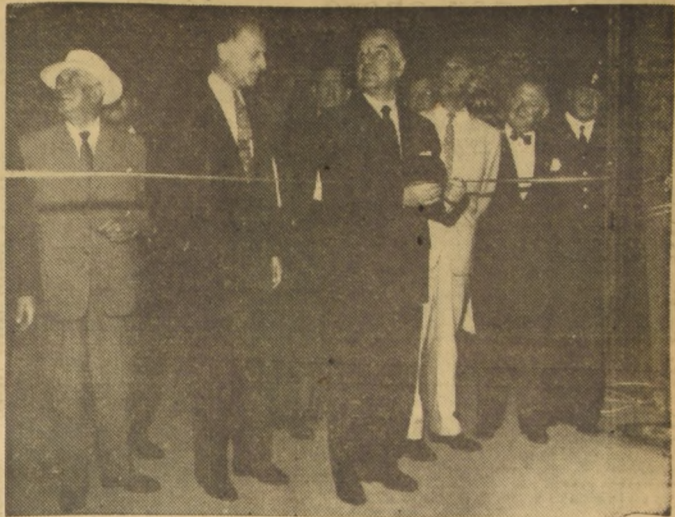
NUEVA RED DE ALUMBRADO.— Ayer fue inaugurada una nueva red de alumbrado público con 46 ampolletas luminarias de vapor de mercurio que abarcan el sector de Avenida José María Caro entre Plaza Baquedano y puente Independencia. El grabado corresponde al instante en que el Intendente-Alcalde, Ramón Álvarez Goldsack corta la huincha tricolor chilena, durante el acto inaugural, mientras le acompaña el presidente de la Compañía Chilena de Electricidad, Arturo Aldunate Phillips, y observan autoridades y altos funcionarios de la misma empresa.
