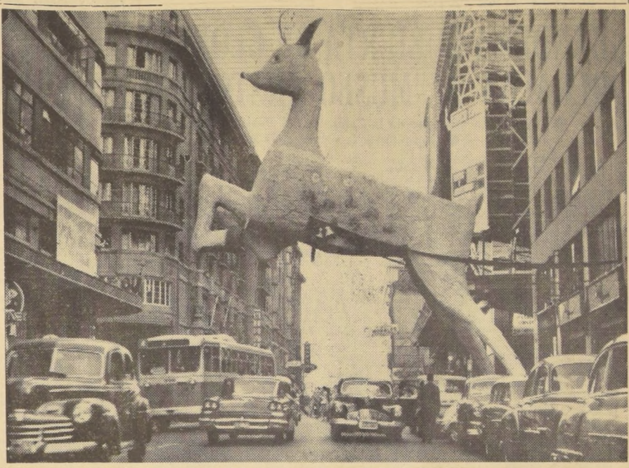
Este gigantesco ciervo alza desde ayer su grácil estatura en plena calle Estado. Pareciera que está dispuesta a brincarse, pero su movimiento está sostenido por una extraordinaria obra de ingeniería. Dos cables de acero, empotrados en lo alto de los edificios ubicados en esa vía con calle Huérfanos, lo suspenden. Sus remos posteriores le sirven de base. Este bambi —de cuatro pisos de alto— amaneció en la mañana de ayer brincando para los santiaguinos. Y aunque sirve de propaganda a una tienda, su figura es anuncio y temprano anticipo pascuero.
