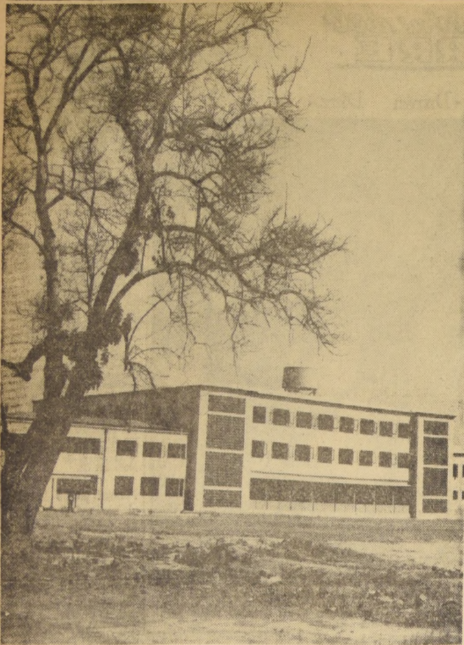
Este es el nuevo edificio que funcionará, desde marzo próximo, la Escuela Industrial de San Felipe. La construcción fue iniciada en 1946 y la obra gruesa del primer pabellón se terminó en 1948. La Dirección de Arquitectura hizo un nuevo estudio de esta obra, fruto del cual fue la determinación de reducir las proyecciones de lo planeado en forma de hacerlos compatibles con la realidad económica fiscal. Así se construyó solo la parte iniciada, en 8 meses y a un costo de 200 millones. El proyecto anterior significaba gastar 1.500 millones, sin plazo fijo.
