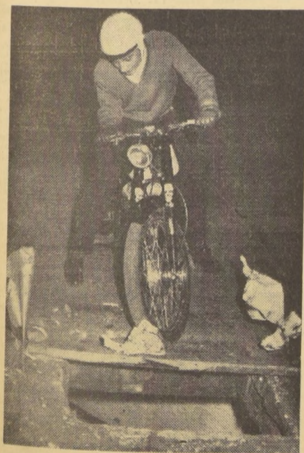
HERNAN VERDUGO alcanzó a frenar antes del hoyo de aproximadamente un metro cuadrado. Este es sólo uno de los tres que existen en plena Plaza de la Constitución, frente a la Moneda. Verdaderos trampas mortales, se abren sobre una alfombra de casi cuatro metros al garage subterráneo que existe allí. Permanecen abiertas desde hace más de un año sin que hayan sido reparadas, pese al peligro que significan para las personas, inclusive niños, y vehículos, y a que llamamos la atención sobre esto hace ya varios meses.
