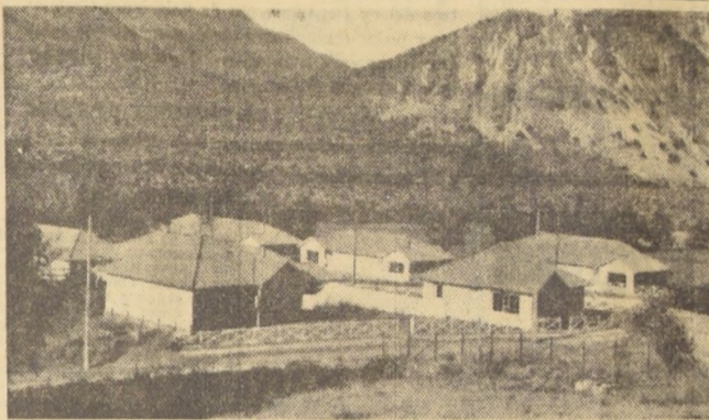
Algunos de los hermosos bungalows, que la Compañía Chilena de Electricidad, entregó a su personal de la Planta Hidroeléctrica de Queltehues.
