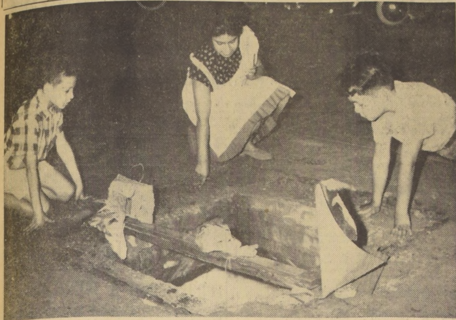
¿Que se espera para tapar el hoyo de la Plaza de la Constitución que, como se ve en el grabado, constituye un verdadero y real peligro para automovilistas, motonetas y peatones, y entre éstos últimos, especialmente para los niños? Para colocar una tapa se aguarda, acaso, que alguien sufra un accidente, como acaba de ocurrir en la comuna de Las Condes.
