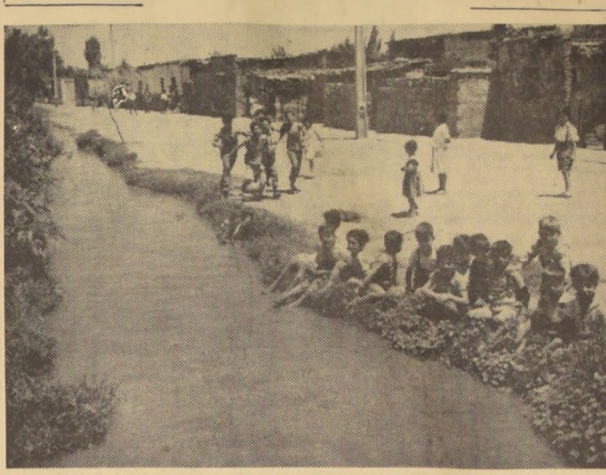
Este canal, que corre a tajo abierto y que cruza de extremo a extremo la Población "Los Nogales", fue calificado por los técnicos municipales como "lo peor" encontrado durante la inspección realizada en toda la comuna.
