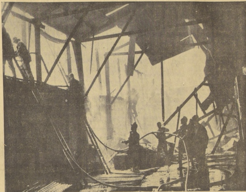
Nuevamente, ayer, los voluntarios de las Compañías de Bomberos, debieron desplegar arduas tareas, para atacar el fuego. Dos siniestros registrados en la mañana, destruyeron fábricas y dañaron cuatro propiedades más. EN EL GRABADO, los bomberos escalan paredes para atacar el fuego, antes que siga extendiéndose a viviendas vecinas, luego de destruir la fábrica de juguetes de García Reyes 79. (INFORMACION EN PAG. 5.)
