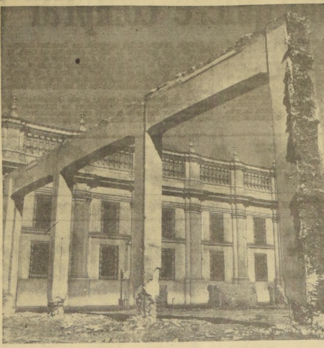
Estos pilares es todo lo que queda del viejo edificio que ocupara, durante medio siglo, el Ministerio de Justicia, en la esquina de Testigos con Moneda, frente al Palacio de Gobierno. Fue demolido para dar paso a un moderno inmueble de cuatro pisos, que ocuparan los Ministerios de Salud, Trabajo y Tierras y Colonización, y otras reparticiones públicas. Antes de ser vendido al Fisco, en 700 mil pesos, en 1927, fue una de las mansiones más lujosas del siglo pasado, donde se celebraron grandes recepciones sociales y reuniones políticas de trascendencia para la época. Desde sus balcones y con la anuencia de los grandes periodistas asistieron muchos sucesos que conmovieron al país y que tuvieron como escenario la plaza que enfrentaba a la casa de Toesca, y donde estaba también el Ministerio de Guerra.
