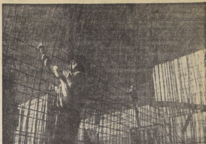
NUOVO LICEO.— En forma acelerada, continúan los trabajos de construcción del Liceo de Talagante. El edificio es uno de los doce que este año levantará la Sociedad Constructora de Establecimientos Educativos en el país. La obra se inició en Talagante el 15 de diciembre pasado y debe estar finalizada, según contrato, el 15 de diciembre de este año. No obstante, la firma a cargo de los trabajos espera entregarla dos meses antes. Será un edificio de dos pisos, con capacidad para 800 alumnos. Además de las salas especiales, dispondrá de un amplio salón de actos, de un gimnasio y de una cancha de basquetbol. Así se verá cumplida una antigua aspiración de los habitantes de Talagante, por cuya materialización trabajaron las autoridades y comités locales durante mucho tiempo. En el grabado, los obreros trabajan en la obra gruesa de lo que será el moderno Liceo de Talagante.
