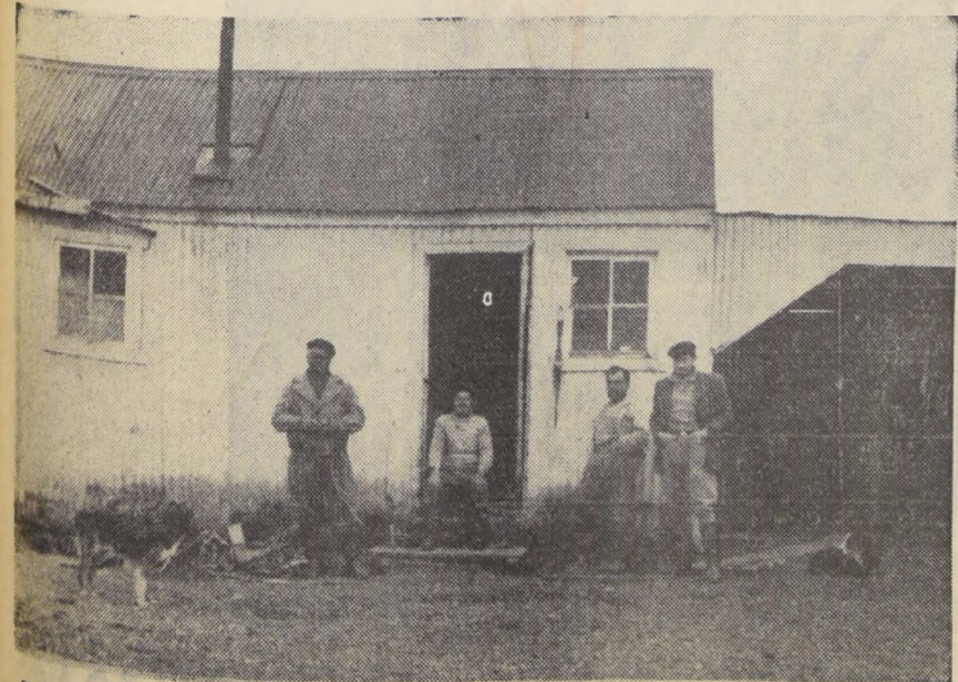
Obreros que trabajan para la Caja de Colonización, durante un breve intervalo de labor, posan, en la puerta de una de las cocinas de la ex Estancia Caleta Josefina. Este gran predio ganadero fue subdividido y entregado en propiedad a cientos de nuevos estancieros de Magallanes.
