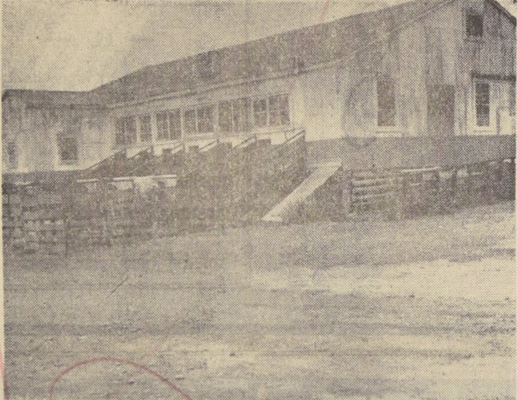
El galpón de esquila, amplio, que cumple totalmente las necesidades de la faena clásica de las estancias de Tierra del Fuego, y que tiene una ubicación muy cercana a las casas principales del establecimiento.
